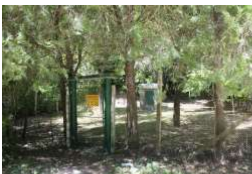
Каптаж отдел 105, подотдел»и», земл.гр.Провадия (снимки А.Янева)
