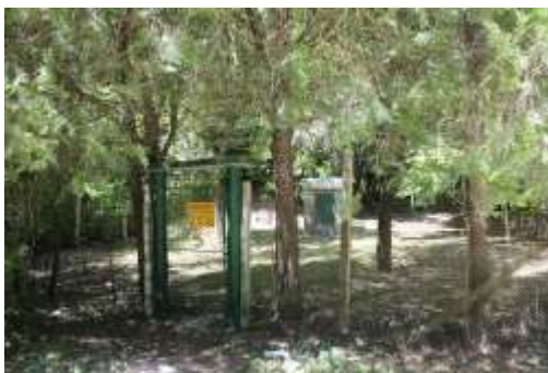
Каптаж отдел 105, подотдел - и, земл.гр.Провадия (снимки А.Янева)
